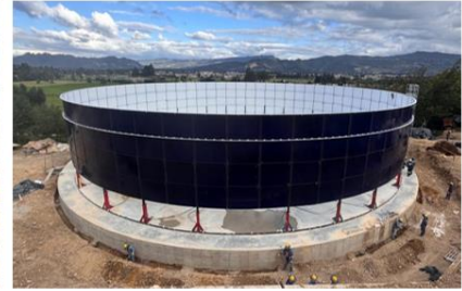
Terminación de placa, canal en ejecución y ensamble de primeros seis anillos del tanque Periodo Noviembre-Diciembre 2024
