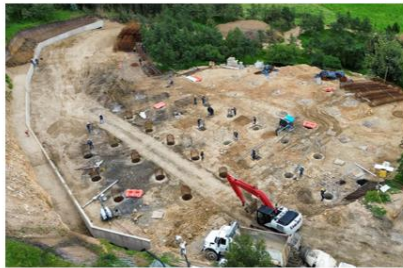
Excavación manual para cimentación tipo caisson periodo Enero-Julio 2024
