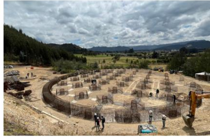
Armado de acero para vigas placa y dados, con fundida de caissons Periodo Agosto-October 2024
